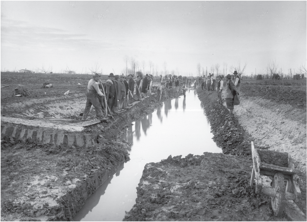
1. Lavori di scavo di un canale nei terreni acquitrinosi al bordo della laguna veneta, zona di Altino, anni 20 del XX secolo. (archivio privato).
